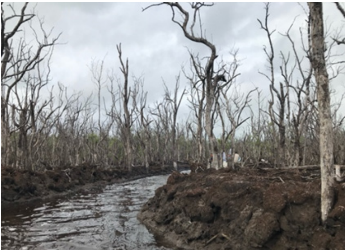
Figura 100. Desazolve de canales primarios. Créditos: Beatriz Del Valle, 2024.
